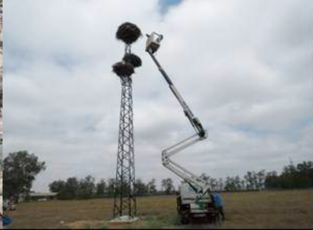
Photo 2. Nacelle utilisée pour le contrôle des nids
