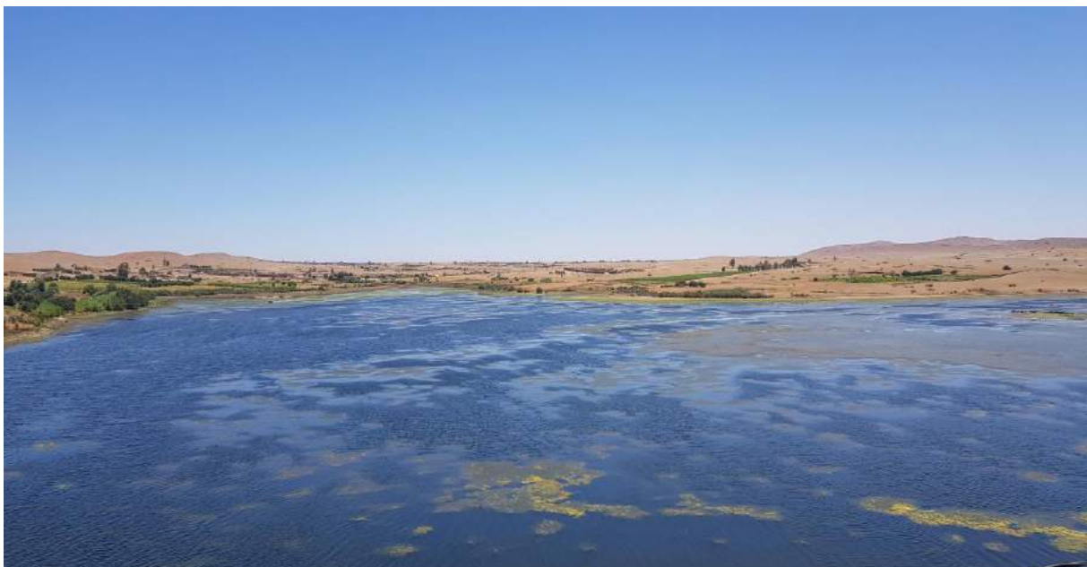
Photo 3. Le barrage collinaire d'Ouled Abbas
